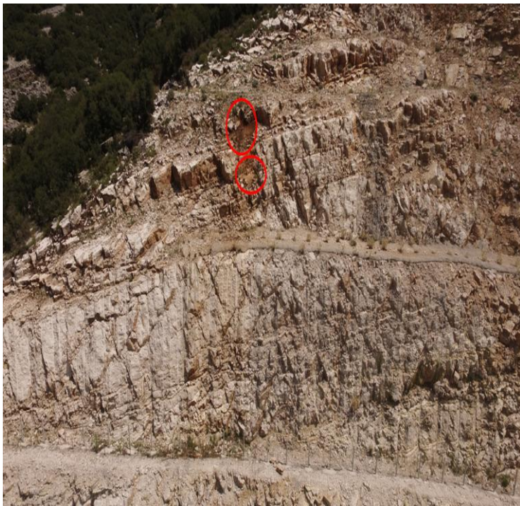
Σημείο αποκόλλησης τεμαχίων
